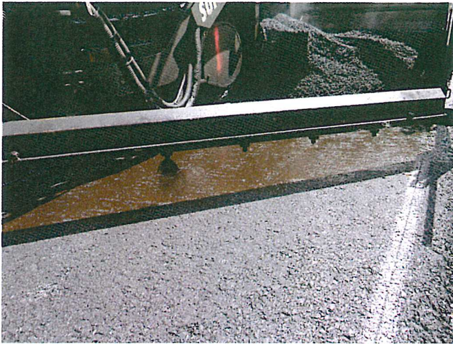
Anspritzen direkt vor dem Asphalteinbau
