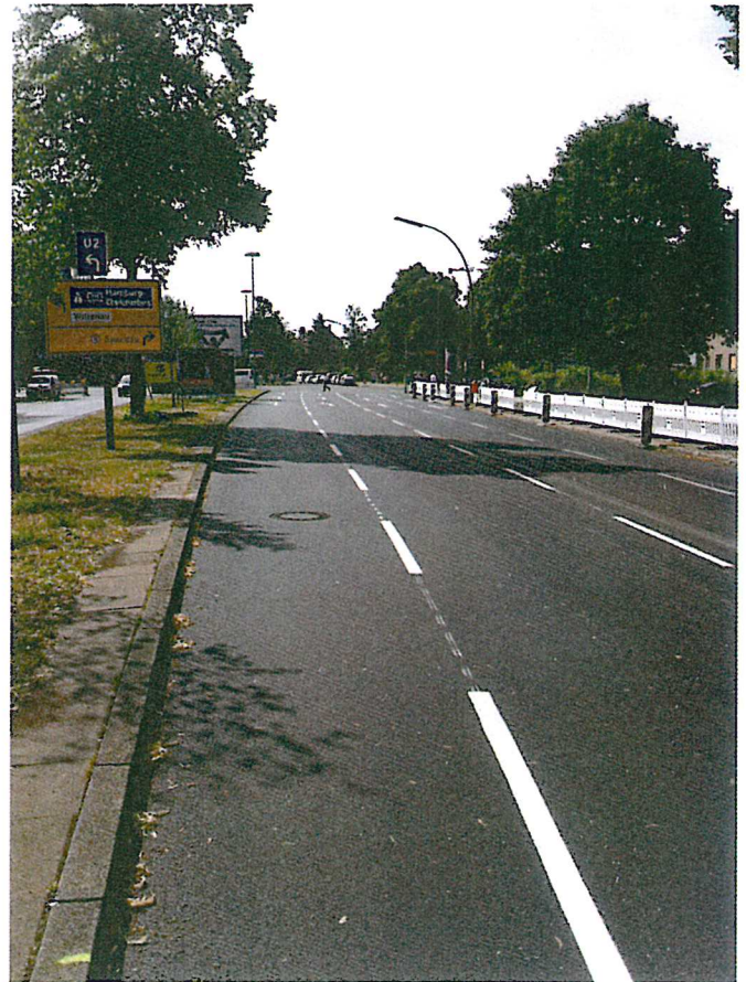
Berliner Straße zum Ende der Bauausführung
