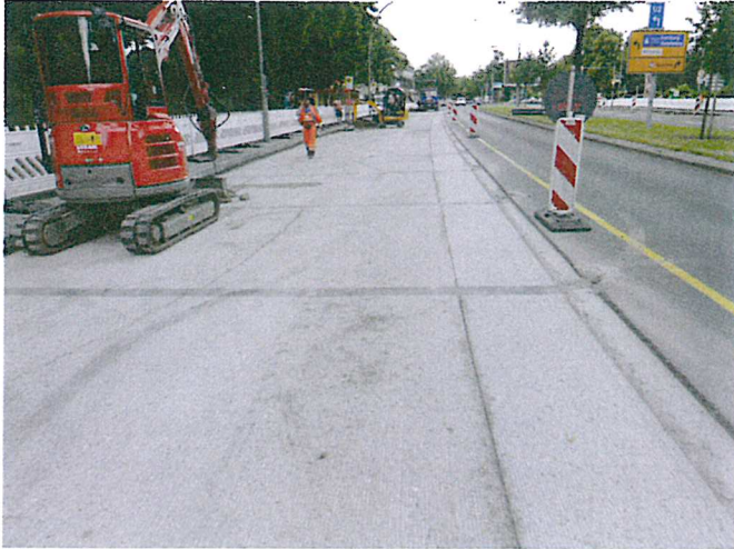
Aufbau auf typischer Berliner Betonunterlage
