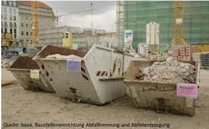
Quelle: baulogik, Baustelleneinrichtung Abfalltrennung und Abfallentsorgung
