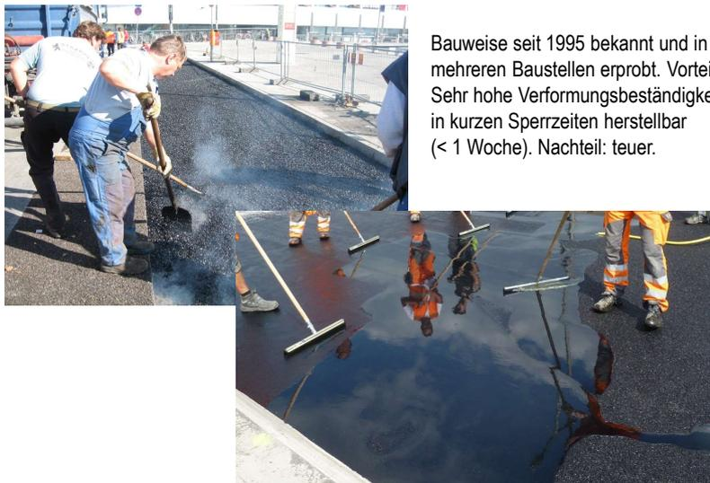
Bauweise seit 1995 bekannt und in mehreren Baustellen erprobt. Vorteile: Sehr hohe Verformungsbeständigkeit und in kurzen Sperrzeiten herstellbar (< 1 Woche). Nachteil: teuer.
