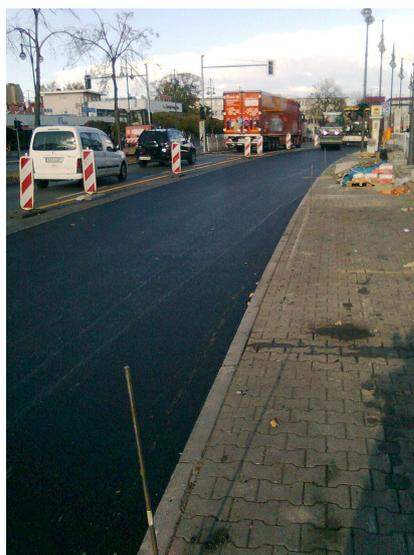
Neu eingebaute Deckschicht aus Splittreichem Asphaltbeton AC 8 D SP in einer Bushaltestelle.
