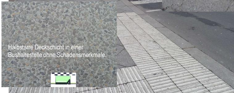
Halbstarre Deckschicht in einer Bushaltestelle ohne Schadensmerkmale.
