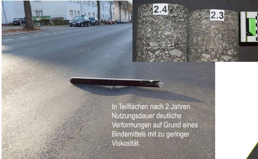
In Teilflächen nach 2 Jahren Nutzungsdauer deutliche Verformungen auf Grund eines Bindemittels mit zu geringer Viskosität.
