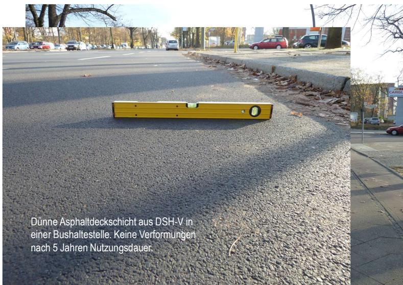
Dünne Asphaltdeckschicht aus DSH-V in einer Bushaltestelle. Keine Verformungen nach 5 Jahren Nutzungsdauer.
