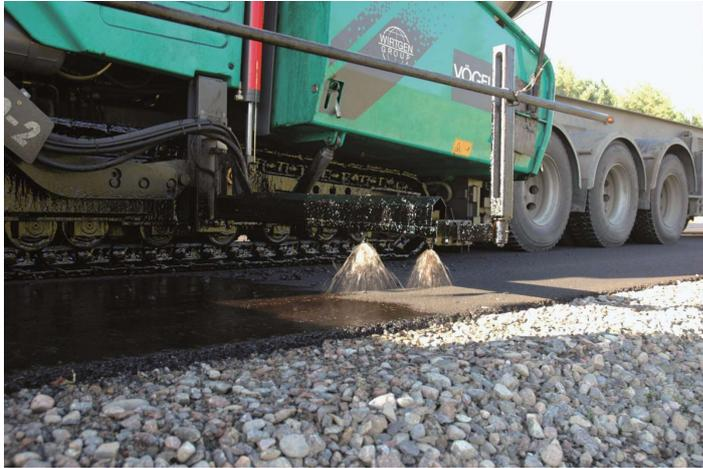
*Herstellung der Versiegelung mit dem integrierten Sprühbalken (System Vögele)*
