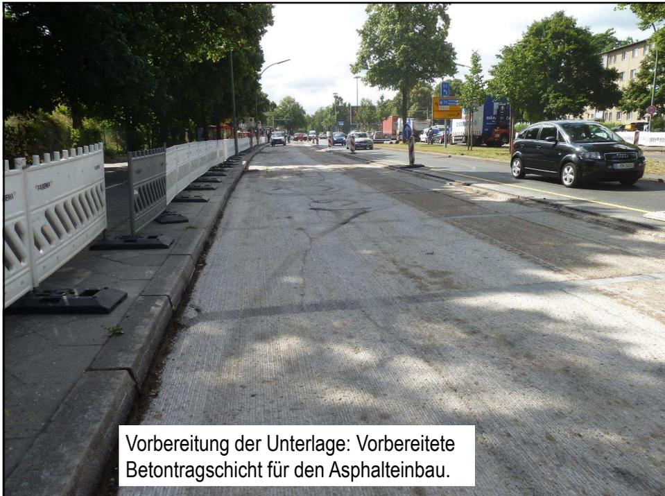
Vorbereitung der Unterlage: Vorbereitete Betontragschicht für den Asphalteinbau.
