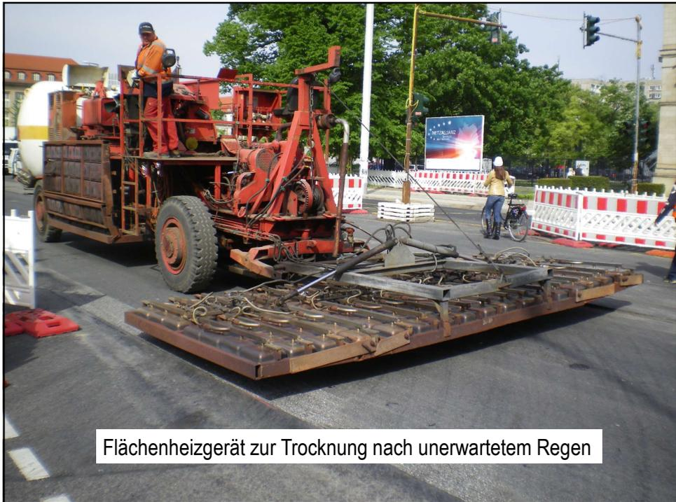
Flächenheizgerät zur Trocknung nach unerwartetem Regen
