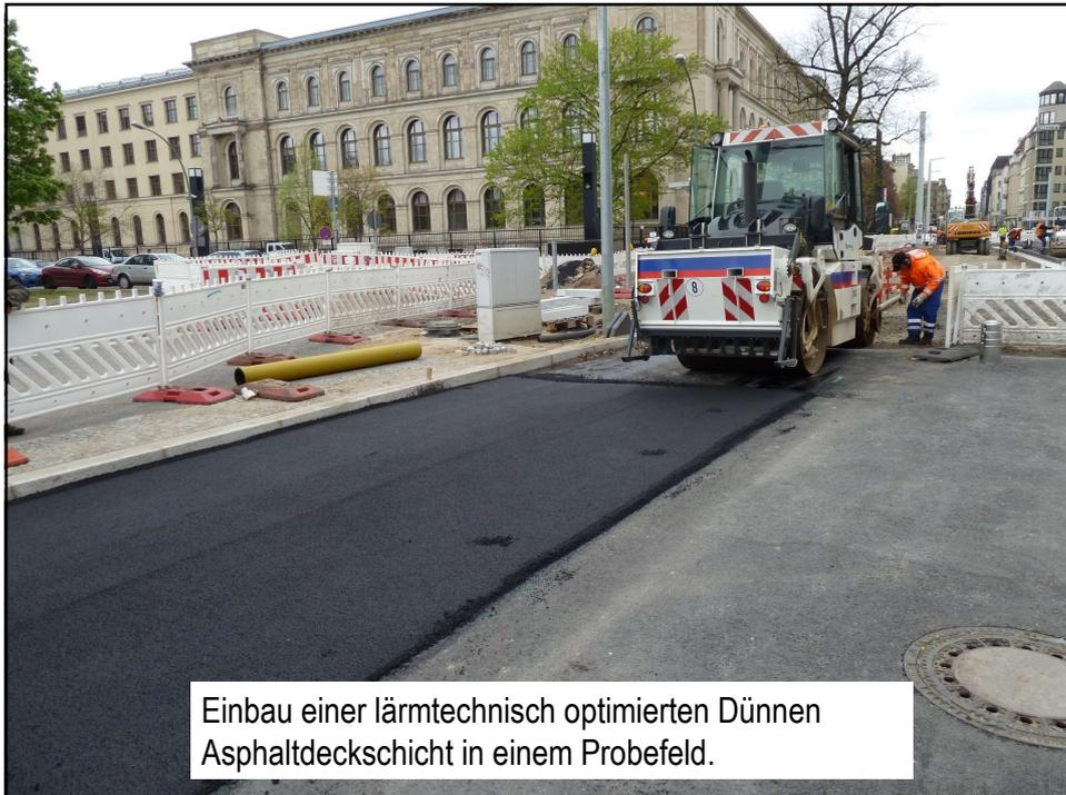
Einbau einer lärmtechnisch optimierten Dünnen Asphaltdeckschicht in einem Probefeld.
